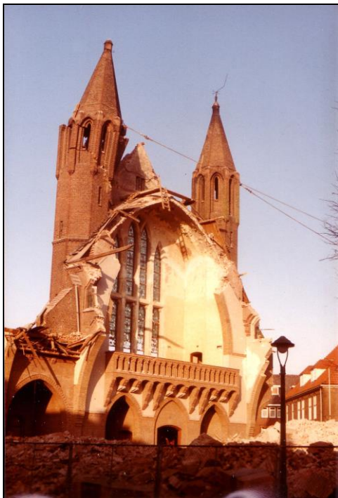
Sloop van de Antoniuskerk De stenen toren van de kerk wordt omgetrokken
