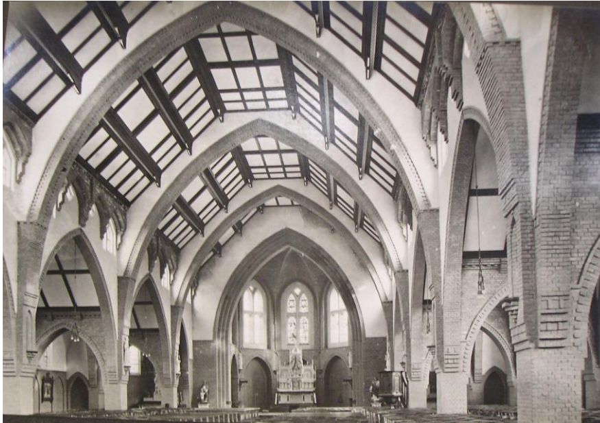
Interieur van de Antoniuskerk omstreeks 1925. Archief architect W. te Riele NAI Rotterdam
