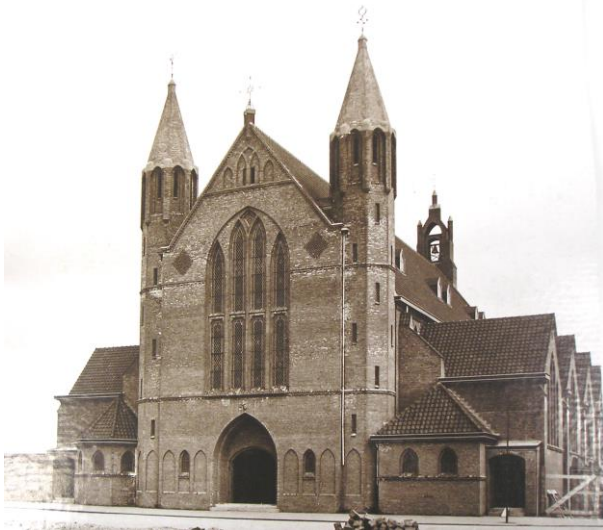
Voorgevel Antoniuskerk, kort na de oplevering in 1924. Afbeelding: Archief van architect W. te Riele; NAI Rotterdam
