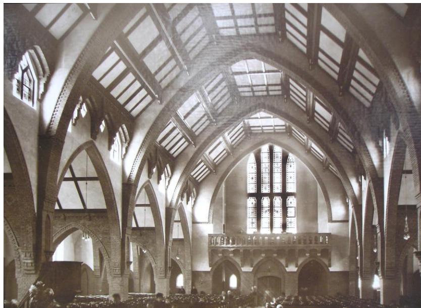
Interieur van de Antoniuskerk, gezien in westelijke richting, kort na het gereedkomen van het gebouw in 1924. (Foto: Archief van architect W. te Riele, NAI Rotterdam)
